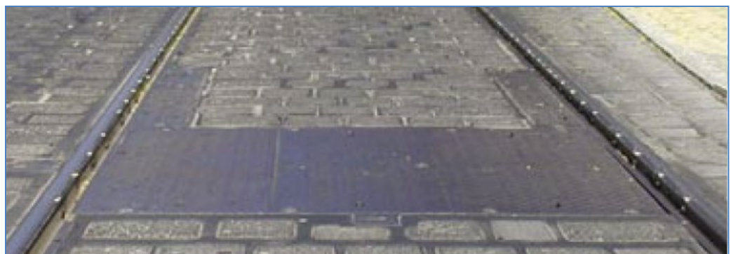
Figuur 13: Locatie met smering van kop en flens via smeerkkanalen bij het railprofiel
