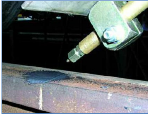
Figuur 9: Voertuiggebonden kop smering, ook wel aangeduid als TOR smering, Top-Of-Rail
